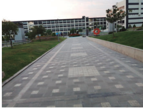
MANTENIMIENTO LOSETONES – UNIVERSIDAD DE LIMA
