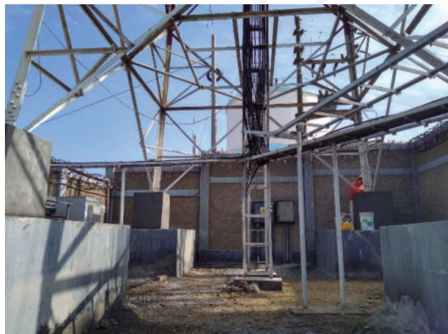
REFORZAMIENTO DE TORRES - ENTEL
