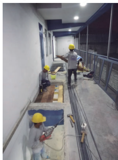
AMPLIACIÓN DE LOSAS – COLEGIO PAMER
