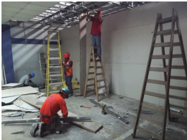
AMPLIACIÓN DE LOSAS – COLEGIO PAMER
