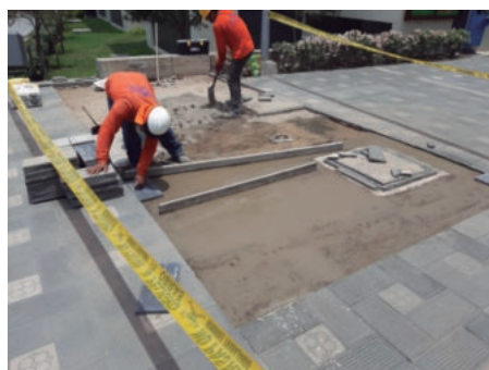
MANTENIMIENTO LOSETONES - UNIVERSIDAD DE LIMA
