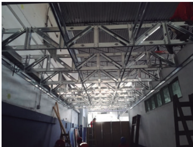
ADECUACIÓN DE AULAS – COLEGIO PAMER
