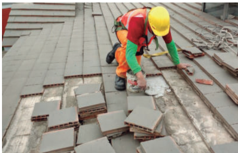
MANTENIMIENTO TECHOS - COLEGIO ABRAHAM LINCOLN
