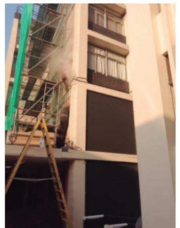
TARRAJEO FACHADAS - UNIVERSIDAD DE LIMA
