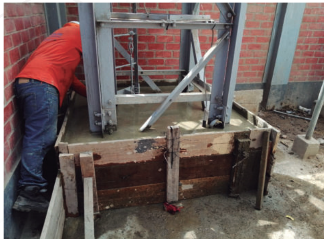
REFORZAMIENTO DE TORRES - ENTEL
